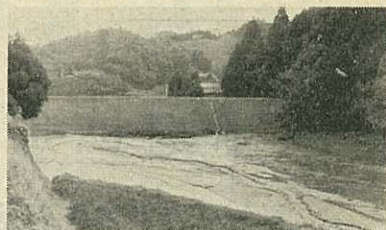
復旧された上分ため池
