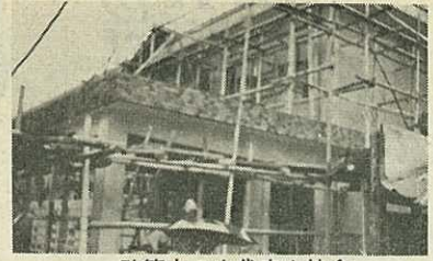
改築中の山代東小校舎
