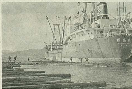
伊万里港でのラワン材荷揚げ作業
