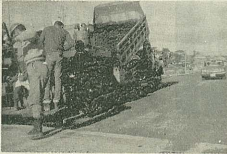
県道伊万里武雄線平尾地区舗装工事
