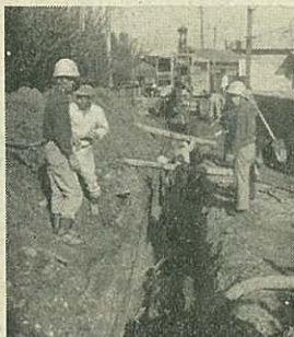
水道本管敷設工事が始まった萱村線
