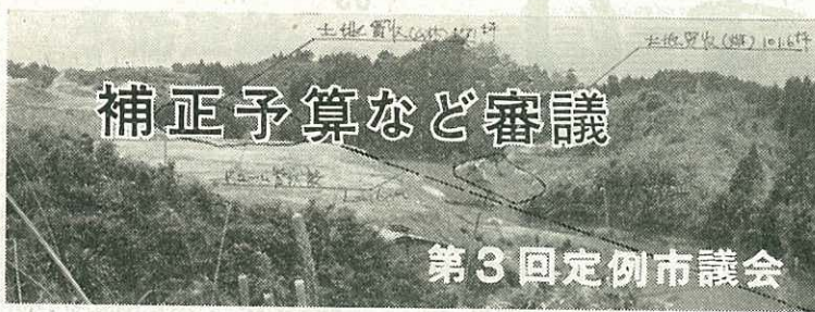
写真は国見台公園野球場建設現場
