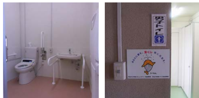
↑二里公民館に新しく整備された障害者トイレ
