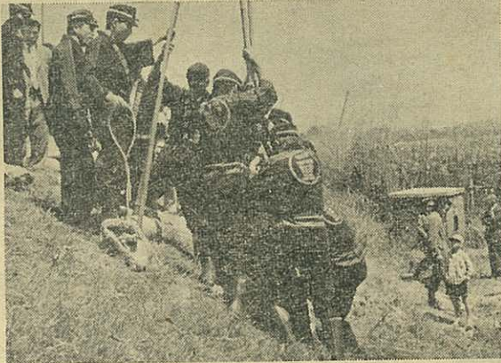
写真上 堤防のき裂防止(五徳縫工法)の訓練(市消防団員) 説明下 救助艇を使用しての警備演習(警察機動隊)
