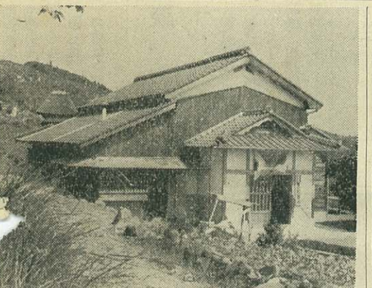
写真は9月30日落成した屋敷野公民館 (建坪47.5坪)
