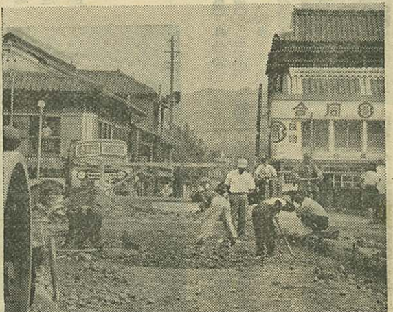
面目を一新する浜町通りの舗装工事
