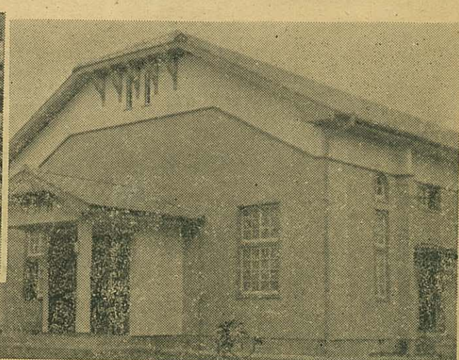
木の香も新らしき東黒川小学校講堂 (9月竣工)
